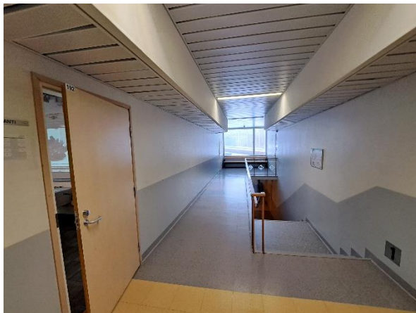
Kuva 21. Käytävälle on asennettu vinyylilaattapinnotteet vuonna 2017.
