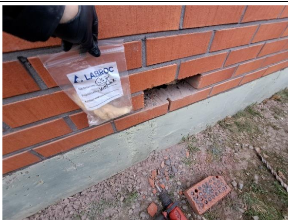
Kuva 33. Ulkoseinät ovat tiili- villa- tiili rakenteisia. Ulkoseinän eristeistä otettiin mikrobimateriaalinäytteitä irrotettujen tiilien ja porareikien kautta.
