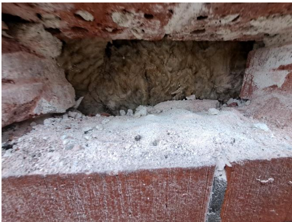
Kuva 35. Etupihan puolella ulkoseinän eristeenä kivivillaa.
