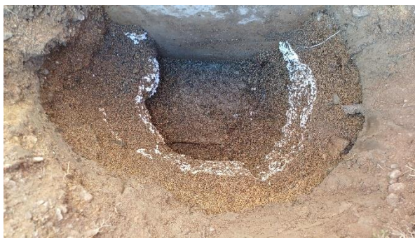
Kuva 9. Sokkelin vieren kaivaus kotitalousluokan vierellä: antura.
