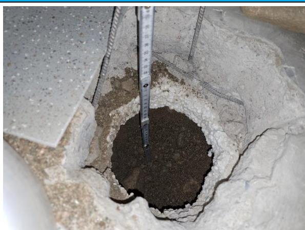
Kuva 20.3 Yleiskuva alustäytön kiviainesta
