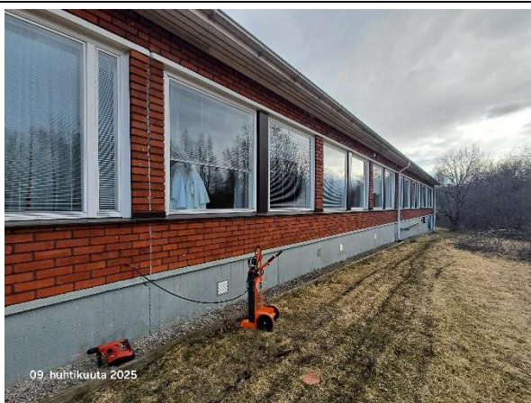
Kuva 43. Merkkiaineekaasututkimuksen alipaineistuslaitteisto. Merkkiaineekaasua johdettiin ulkoseinärakenteen eristetilaan ulkopuolelta
