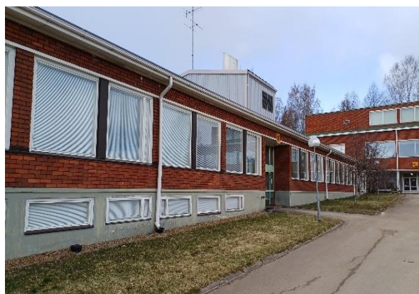
Kuva 4. Etupihan puolella maanpaineiseinällisellä osuudella salaojan tarkastuskaivot.
