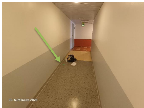
Kuva 29. Käytävän viiltomittaus pinnoitteen alta kotitalousluokan edestä.
