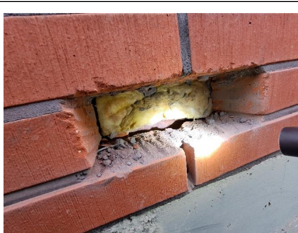
Kuva 34. Ulkoseinissä on eristeenä, sekä lasi- että kivivillaa (mineraalivillaa).
