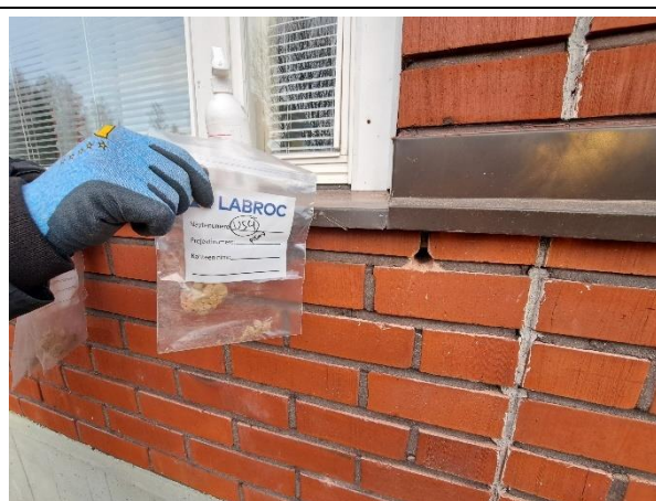
Kuva 48. Ulkoseinän eristetilan mikrobinäytteenotto porareian kautta
